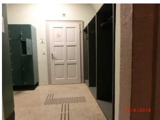
WC-Tür und Wegeleitsystem
